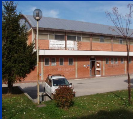
C. COLLI Palazzetto Via Rigopiano
