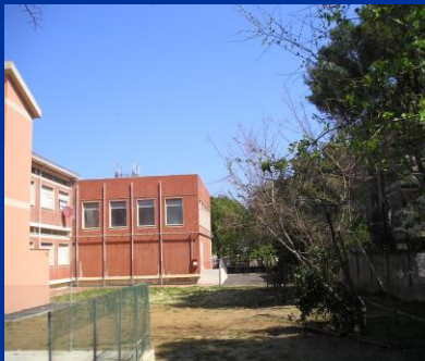
C. PORTA NUOVA Scuola Elem. Via Scarfoglio
