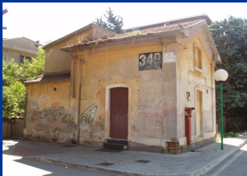
C. CASTELLAMARE SPAZIO PER ANZIANI EX CASELLO FERROVIARIO
